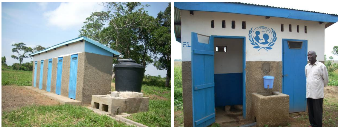
Illustration 12 : Exemple d'ouvrages de grande qualité : les installations sanitaires de quelques écoles du Bas-Congo (ici, EP 4 Boko et EP Kunda Masangu)
