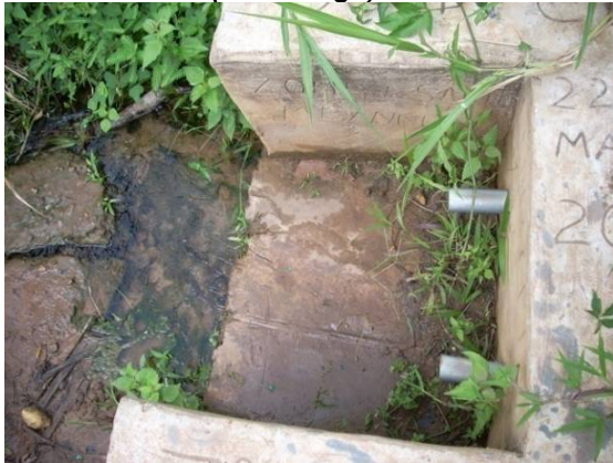
Illustration 14 : Exemple d'une source aménagée mal entretenue (Bas-Congo)
