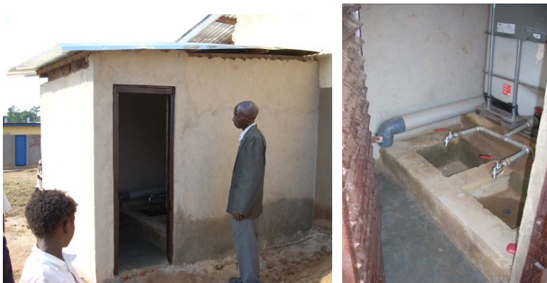
Illustration 17 : L'ouvrage de protection du point de lavage des mains construit par l'EP 2 Kola (Mbanza Ngungu, Bas-Congo)
