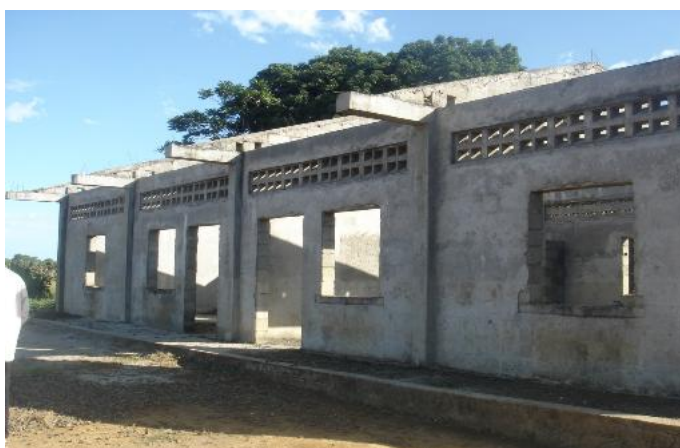
Le nouveau bâtiment inachevé de l'EPP d'Anosivelo
