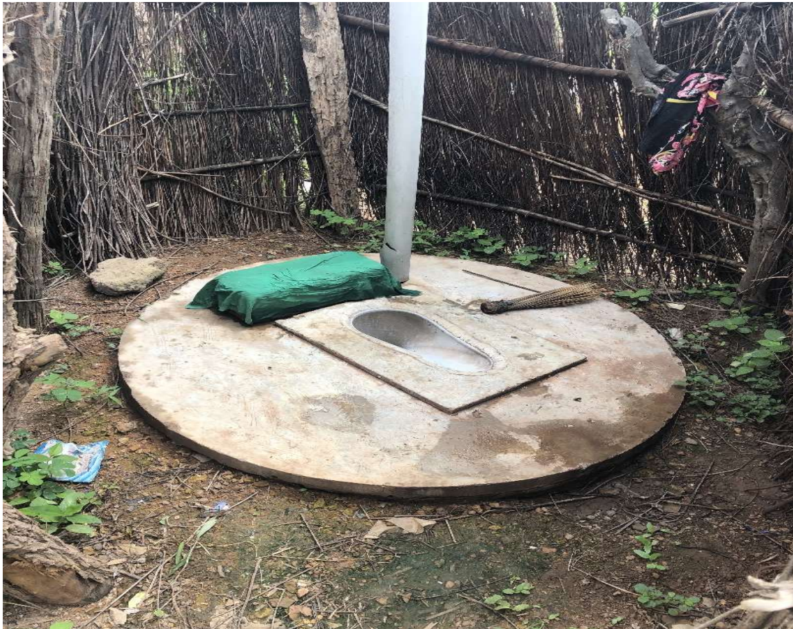
© AMD International : Intérieur d'une latrine dans la région de Tambacounda,
