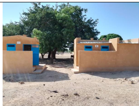
Vue des blocs de latrines séparés fillee -garçons avec un cabines GHM dans le bloc des filles
