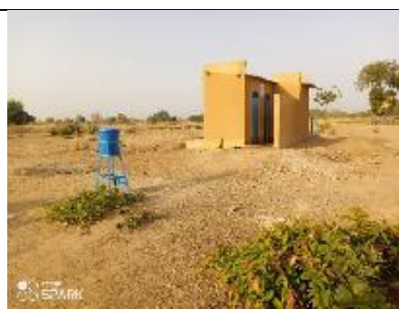
Vue d'un bloc de latrines avec dispositif de lavage des mains (DLM).
