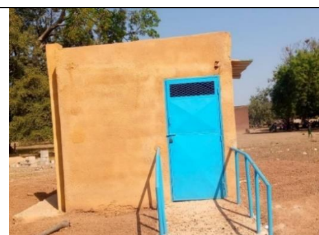
Vue d'une cabine spacieuse munie de rampe d'accès pour les PMR
