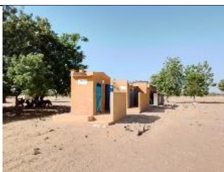
Vue des latrines à l'école Tampoudy
