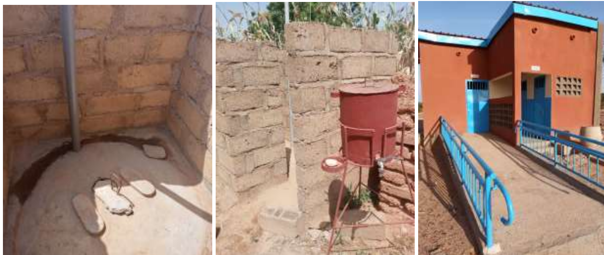
Crédit photo 2 : Image 1 latrine d'un ménage et son DLM (image 2) dans le village de Ouera, province du Bouliké dans la région du centre Ouest. Image 3 latrine institutionnelle avec rampe d'accès pour les élèves vivant avec un handicap d'une de l'école primaire de Djoena, province du Gourma dans la région de l'EST
