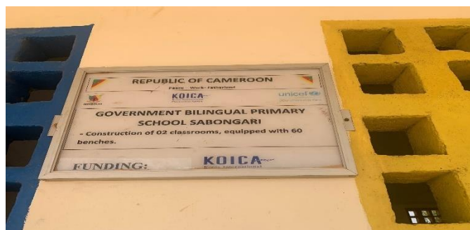
Image 6.11: Plaque informative d'une infrastructure scolaire et de son équipement à Sabongari, Commune de Garoua Boulai
