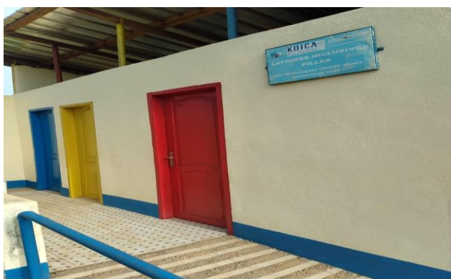
Image 6.6: Bloc de latrines, Village Mbal, Commune de Garoua-Boulai
