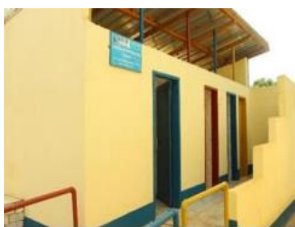
Image 6.3: Construction de nouvelles toilettes pour les filles à Ounsounou, Commune de Ouli
