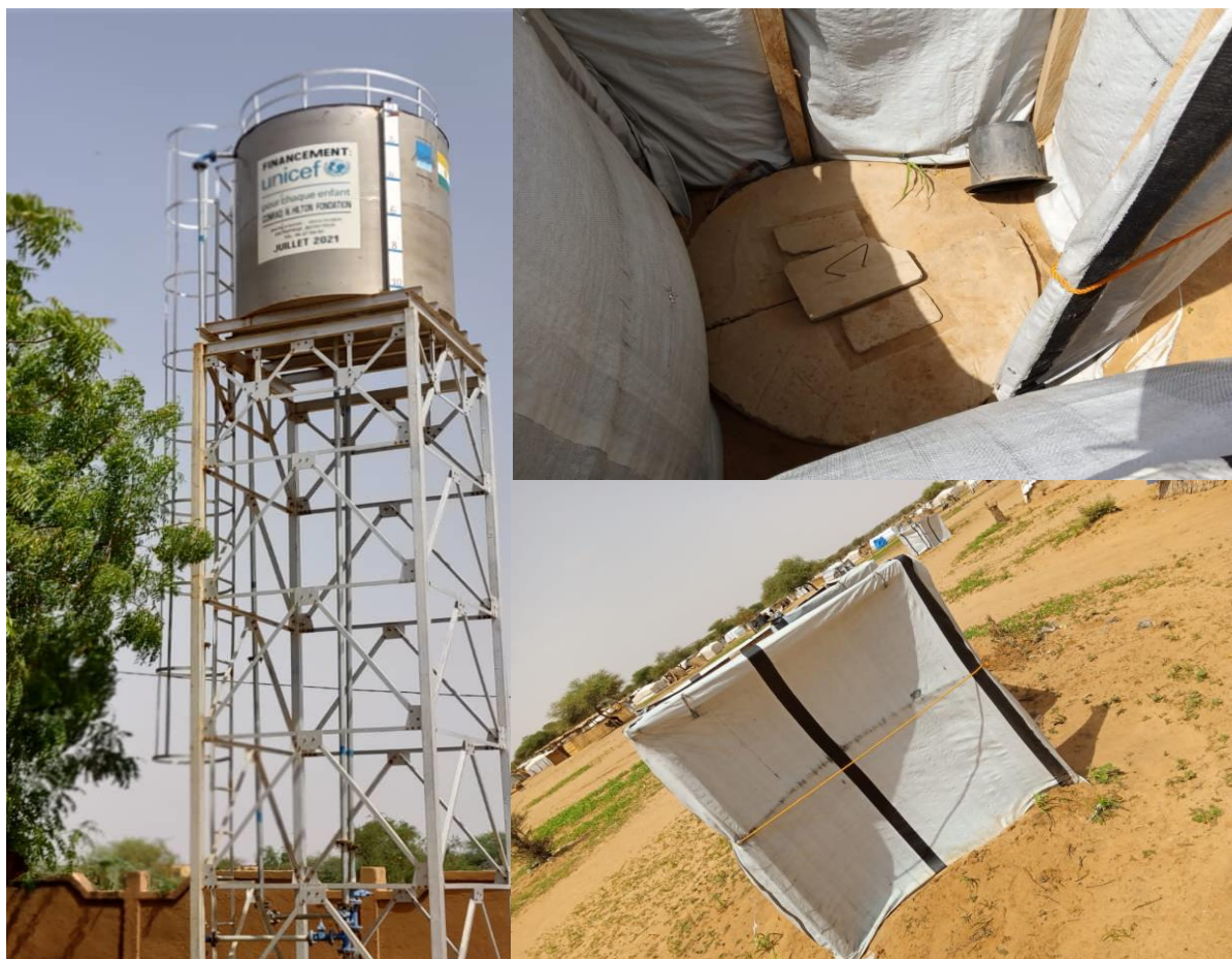
© Collecte AMD International 2023, Château d'eau du CSI de Tillabéri (a) financé par UNICEF et une latrine (b et c) pour PDI dans le grand site de la commune de Gothèye
