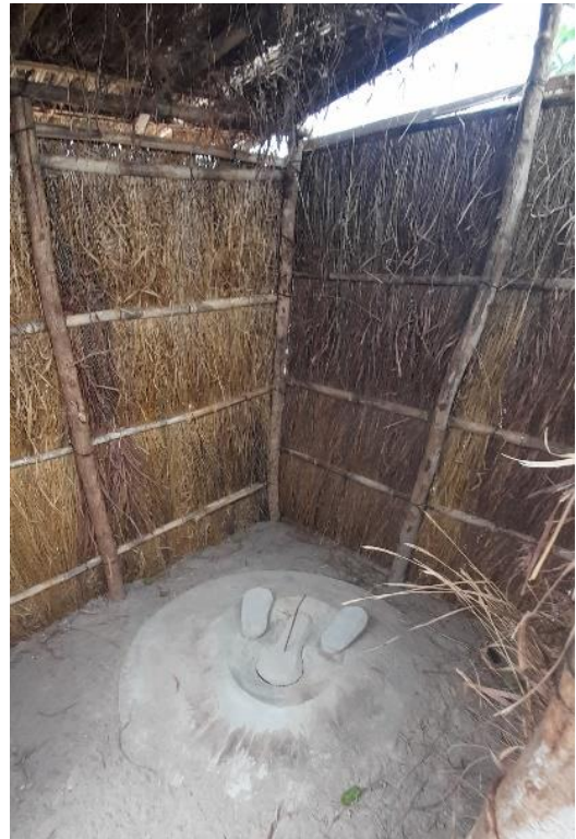
Figura 3.5: Laje de cimento para latrina, Metuge
