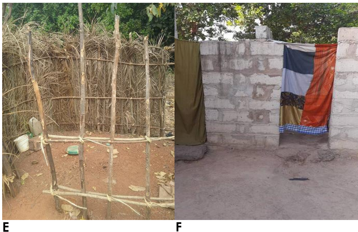
Illustration 3 : Des latrines familiales avec superstructures construites avec des matériaux locaux (E) et définitifs (F) en Guinée Bissau
