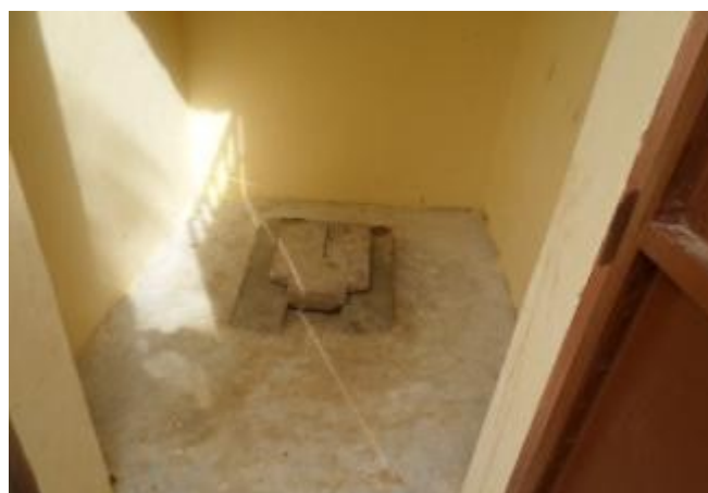
Latrine de l'école de Kendé, vue intérieure, cercle de Bandiagara, Région de Mopti
