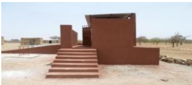
Latrine de l'école de Simérou, cercle de Koro, région de Mopti
