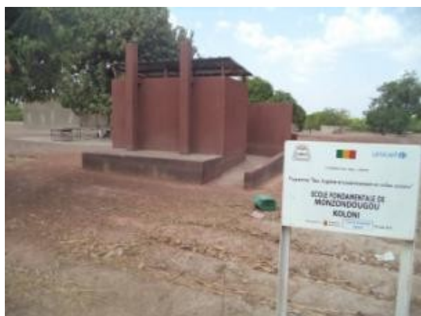
Latrine de l'école de Monzondougou Koloni à Zantiébougou
