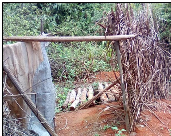
Illustration 7.1.4 : Exemple de fosse simple recouverte de planche de bois dans les zones d'intervention du programme ATPC
