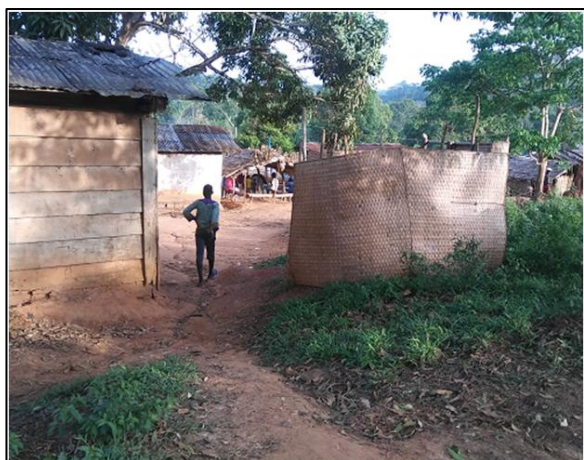
Illustration 7.1.3 : Latrine dans la cours d'un ménage de la Préfecture de la Sangha-Mbaéré
