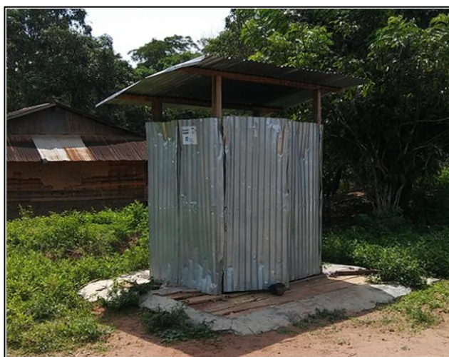
Illustration 7.1.1 : Latrine non fonctionnelle construite par l'ONG FLM dans le village de Mboussa, préfecture de la Sangha-Mbaéré
