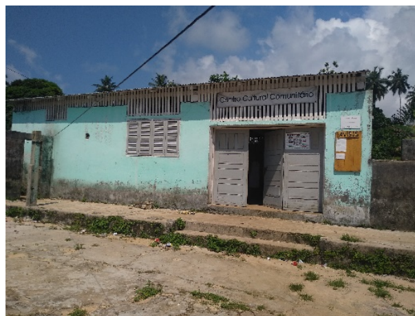
Figura 18 - Centro Comunitário Porto Real
